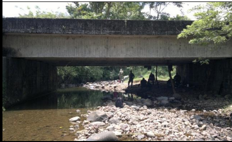
FOTO 3: VISTA PANORAMICA LONGITUDINAL
