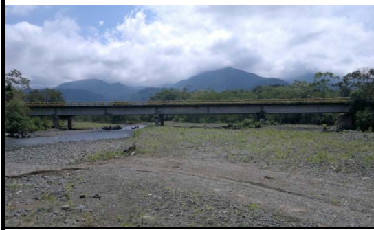
FOTO 3: VISTA PANORAMICA LONGITUDINAL
