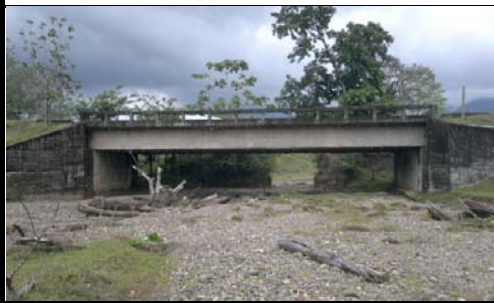
FOTO 3: VISTA PANORAMICA LONGITUDINAL
