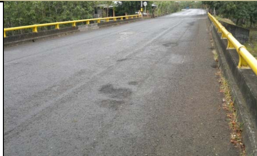
FOTO 2: PLACA IDENTIFICACIÓN PUENTE (NO EXISTE)
