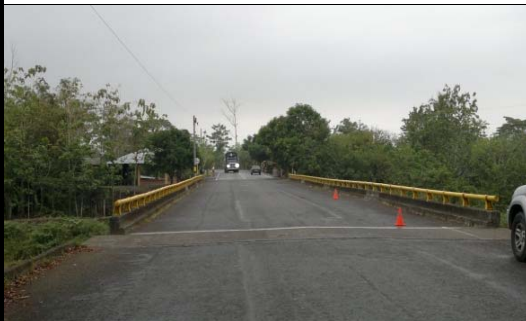
FOTO 3: VISTA PANORAMICA LONGITUDINAL
