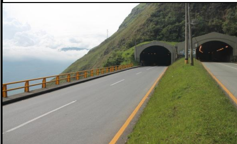
FOTO 3: VISTA PANORÁMICA LONGITUDINAL
