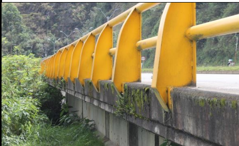
FOTO 3: VISTA PANORÁMICA LONGITUDINAL
