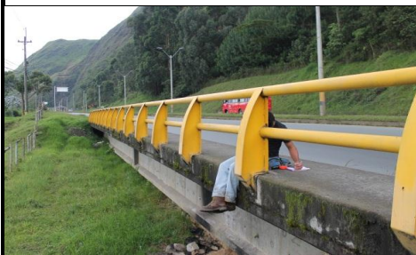
FOTO 3: VISTA PANORÁMICA LONGITUDINAL
