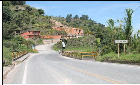
FOTO 2: PLACA IDENTIFICACIÓN PUENTE
