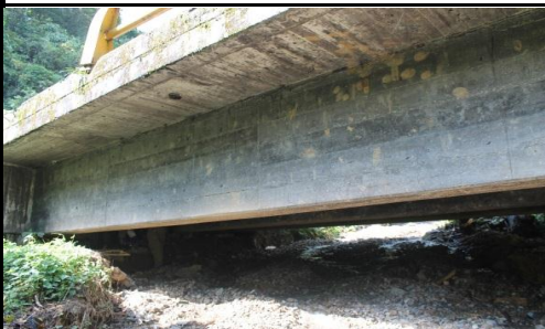
FOTO 3: VISTA PANORÁMICA LONGITUDINAL
