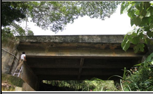
FOTO 3: VISTA PANORAMICA LONGITUDINAL
