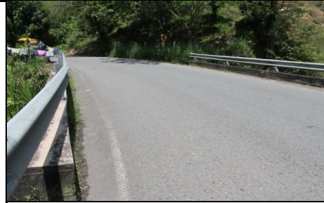
FOTO 2: PLACA IDENTIFICACIÓN PUENTE NO EXISTE
