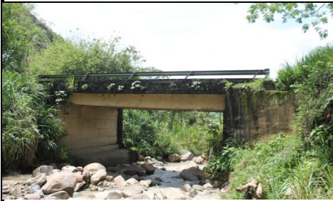
FOTO 3: VISTA PANORAMICA LONGITUDINAL
