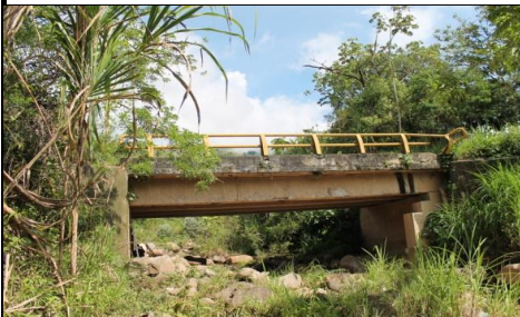
FOTO 3: VISTA PANORÁMICA LONGITUDINAL
