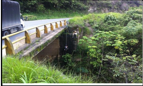
FOTO 3: VISTA PANORAMICA LONGITUDINAL
