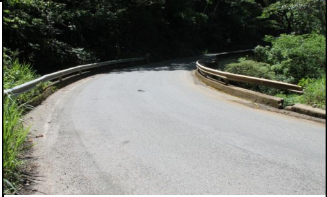
FOTO 2: PLACA IDENTIFICACIÓN PUENTE NO EXISTE
