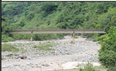
FOTO 3: VISTA PANORÁMICA LONGITUDINAL
