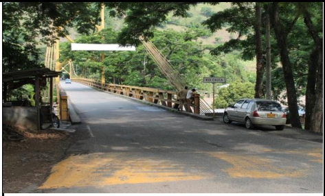
FOTO 2: PLACA IDENTIFICACIÓN PUENTE NO EXISTE
