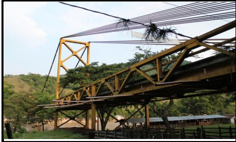
FOTO 3: VISTA PANORAMICA LONGITUDINAL
