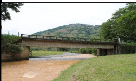
FOTO 3: VISTA PANORÁMICA LONGITUDINAL
