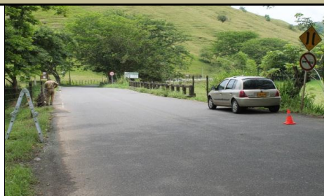
FOTO 2: PLACA IDENTIFICACIÓN PUENTE NO EXISTE
