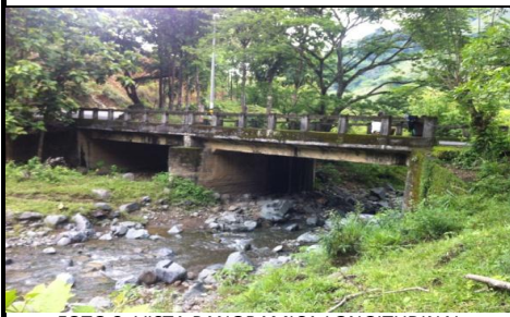
FOTO 3: VISTA PANORAMICA LONGITUDINAL
