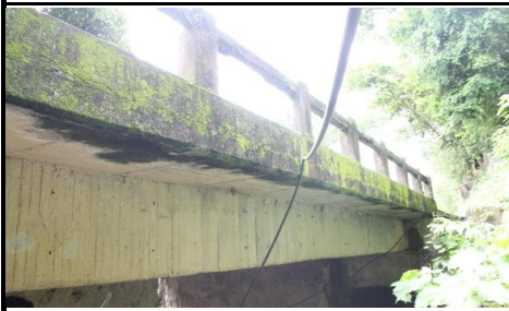
FOTO 3: VISTA PANORÁMICA LONGITUDINAL
