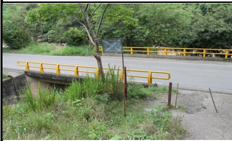
FOTO 3: VISTA PANORÁMICA LONGITUDINAL
