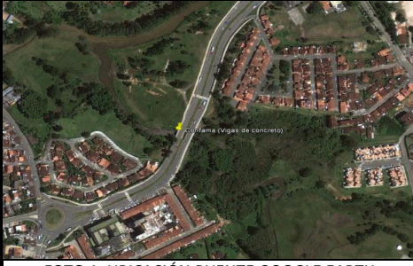
FOTO 1: UBICACIÓN PUENTE GOOGLE EARTH
