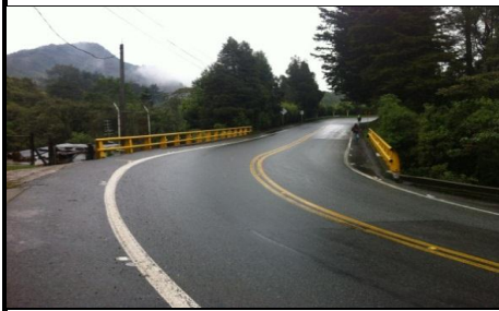
FOTO 3: VISTA PANORAMICA LONGITUDINAL
