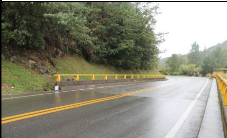
FOTO 3: VISTA PANORAMICA LONGITUDINAL
