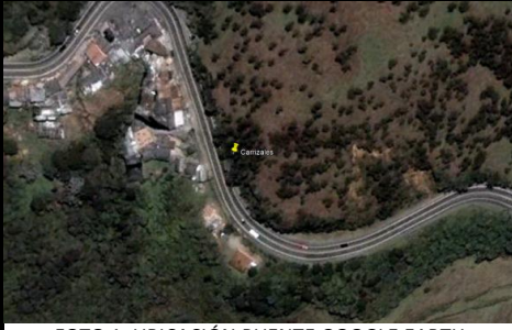
FOTO 1: UBICACIÓN PUENTE GOOGLE EARTH
