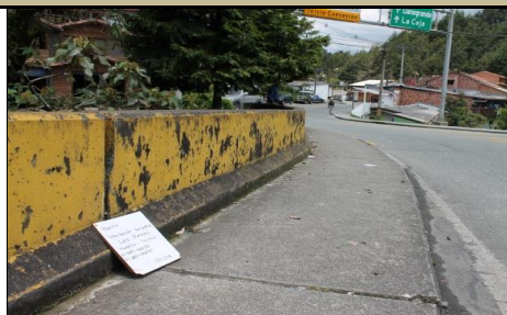
FOTO 2: PLACA IDENTIFICACIÓN PUENTE NO EXISTE
