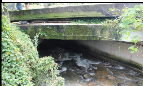
FOTO 3: VISTA PANORAMICA LONGITUDINAL
