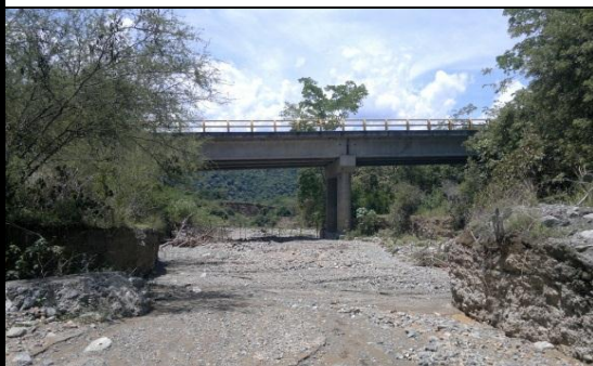
FOTO 3: VISTA PANORAMICA LONGITUDINAL
