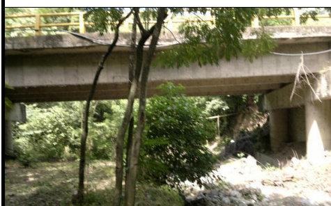
FOTO 3: VISTA PANORAMICA LONGITUDINAL
