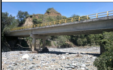
FOTO 3: VISTA PANORAMICA LONGITUDINAL
