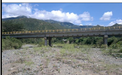
FOTO 3: VISTA PANORAMICA LONGITUDINAL
