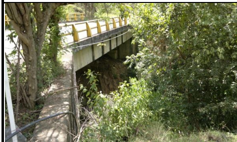
FOTO 3: VISTA PANORAMICA LONGITUDINAL
