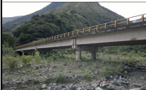
FOTO 3: VISTA PANORAMICA LONGITUDINAL
