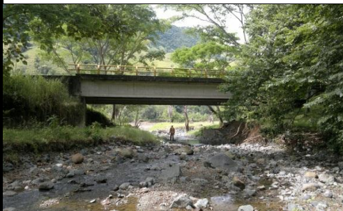
FOTO 3: VISTA PANORÁMICA LONGITUDINAL
