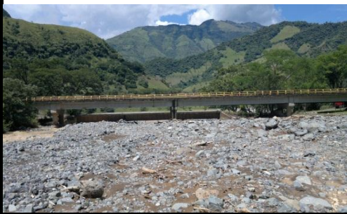
FOTO 3: VISTA PANORÁMICA LONGITUDINAL
