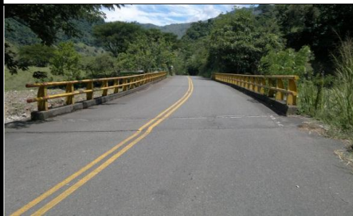
FOTO 3: VISTA PANORAMICA LONGITUDINAL
