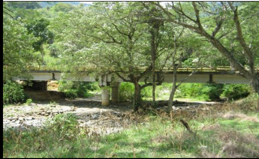
FOTO 3: VISTA PANORAMICA LONGITUDINAL
