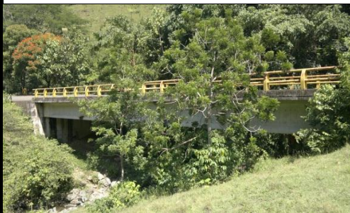
FOTO 3: VISTA PANORAMICA LONGITUDINAL
