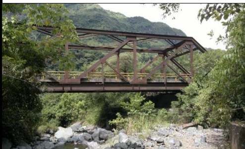
FOTO 3: VISTA PANORÁMICA LONGITUDINAL
