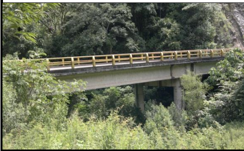
FOTO 3: VISTA PANORÁMICA LONGITUDINAL
