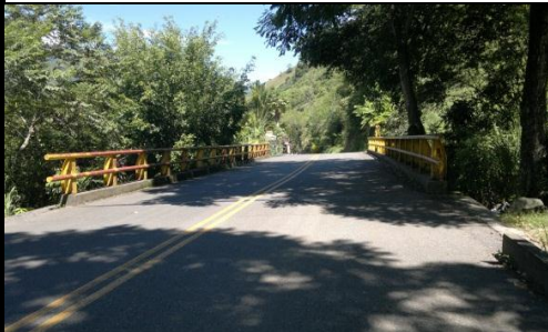
FOTO 3: VISTA PANORÁMICA LONGITUDINAL
