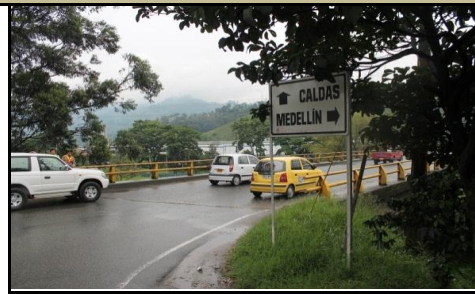
FOTO 2: PLACA IDENTIFICACIÓN PUENTE-NO EXISTE
