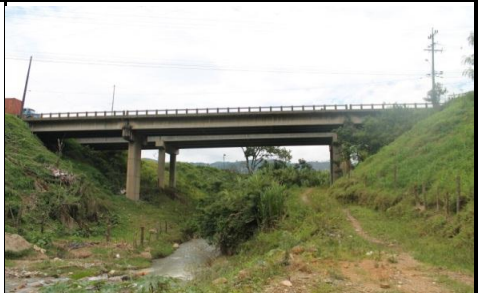
FOTO 2: PLACA IDENTIFICACIÓN PUENTE (no existe)
