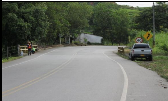
FOTO 3: VISTA PANORAMICA LONGITUDINAL
