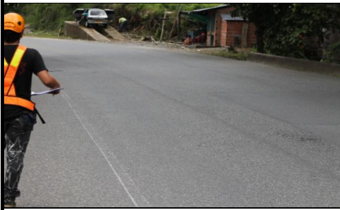
FOTO 3: VISTA PANORÁMICA LONGITUDINAL
