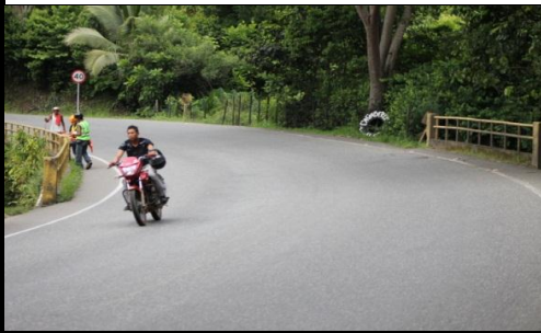
FOTO 3: VISTA PANORÁMICA LONGITUDINAL
