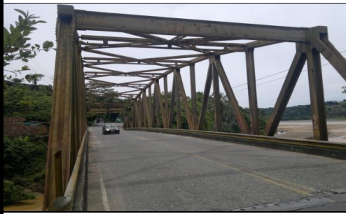
FOTO 3: VISTA PANORAMICA LONGITUDINAL
