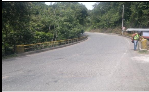
FOTO 3: VISTA PANORÁMICA LONGITUDINAL
