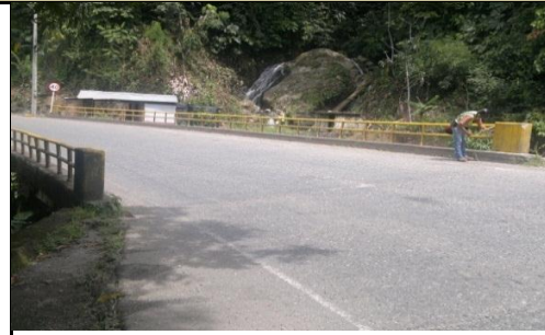
FOTO 2: PLACA IDENTIFICACIÓN PUENTE
