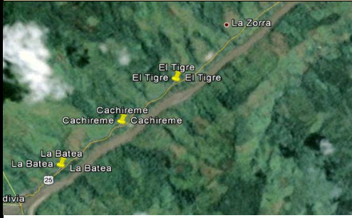
FOTO 1: UBICACIÓN PUENTE GOOGLE EARTH
