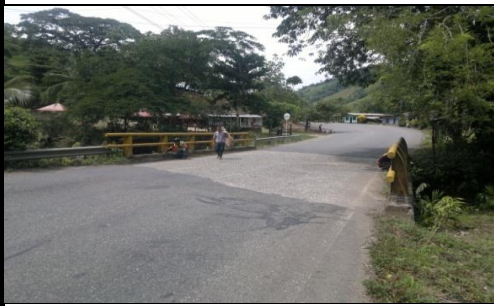
FOTO 3: VISTA PANORÁMICA LONGITUDINAL
