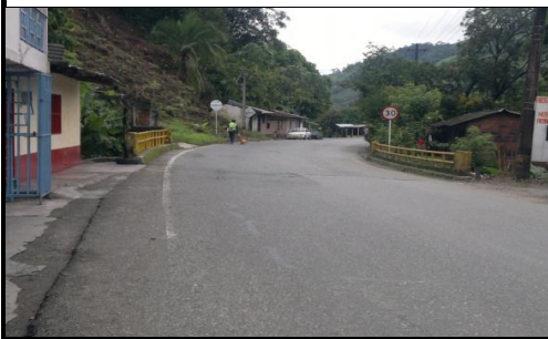
FOTO 3: VISTA PANORÁMICA LONGITUDINAL
