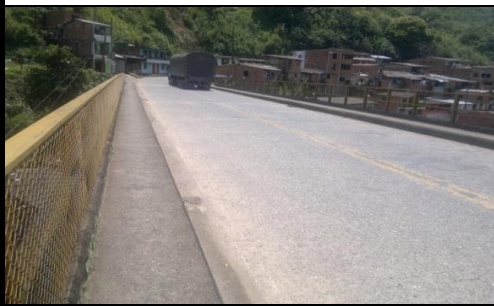
FOTO 3: VISTA PANORAMICA LONGITUDINAL
