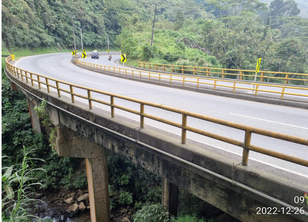
Puente en general
